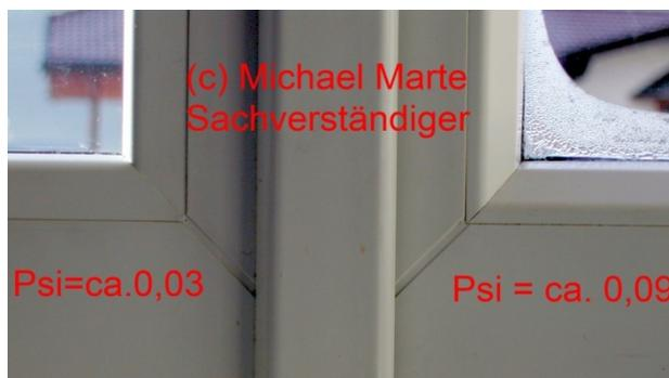
Dieser Einfluss ist bei der Verwendung metallischer Abstandhaltersysteme bei Isoliergläsern deutlich höher als bei (modernen) Kunststoff-Abstandhaltersystemen und variiert bis zu Faktor 4 der Wärmeleitung im Randbereich.
